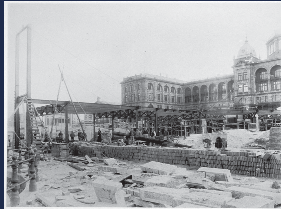
Vanaf het terras van het Kuhrhaus wordt de brug gebouwd over de boulevard die uitliep in de Pier.
