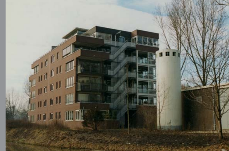
Finnenburg, rioolgemaal. Op de voorgrond de Schenk. Foto R. van Harrewijn
