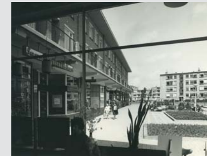
Tarwekamp 1964, winkelcentrum met galerij, erboven maisonnettes, gebouwd in 1960 door architect Wolf
