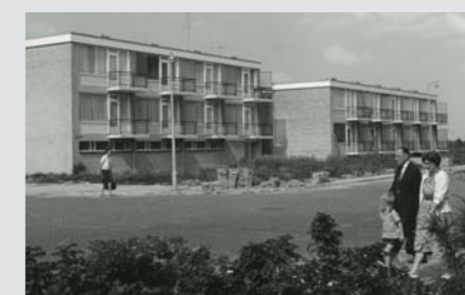
Flats voor alleenstaanden, Robertaland 1964, gebouwd in 1964 door architecten Van Tyen Boom en Posno
