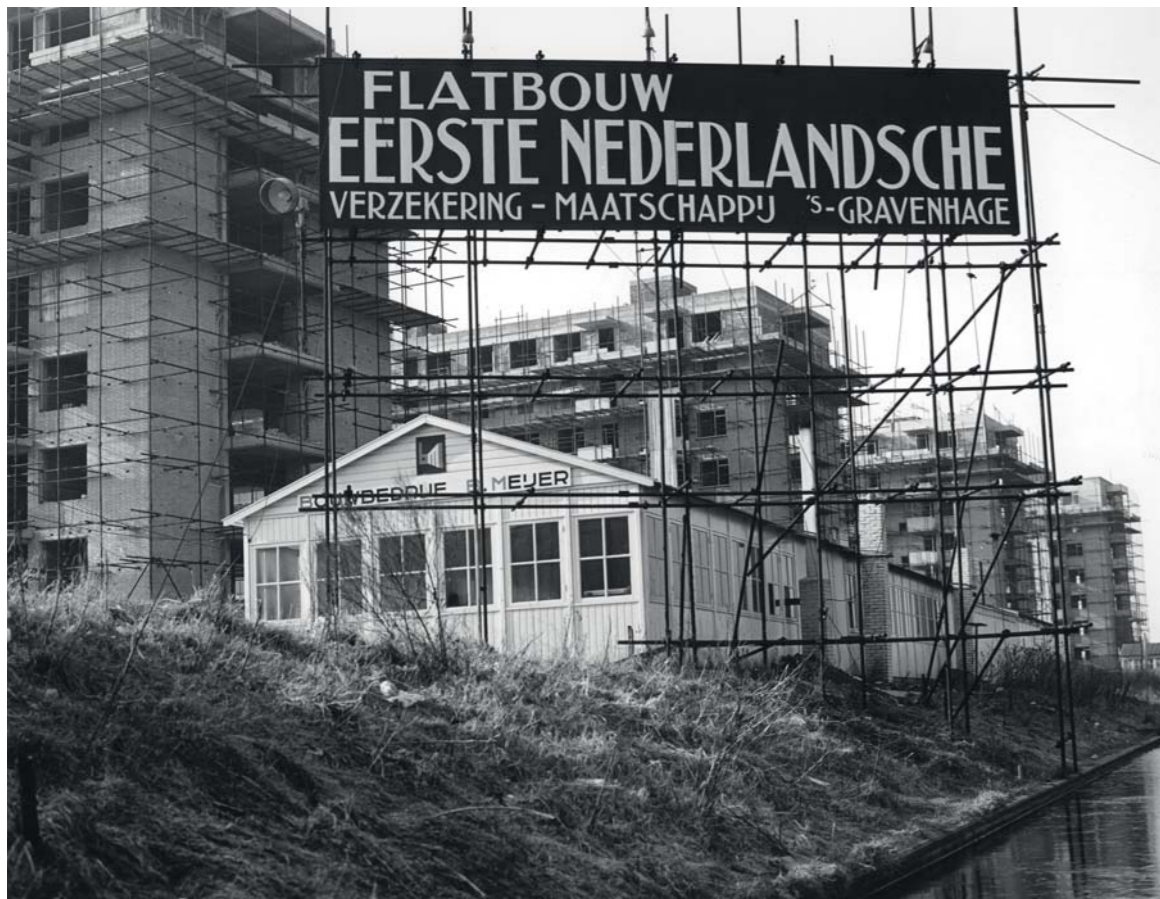
Flats aan de Vlaskamp in aanbouw, 1964, fotoburo Meyer, zeven hoog gelaagd appartementen, drie dwars op het kader staand, gebouwd in 1969 door architect Zanstra
