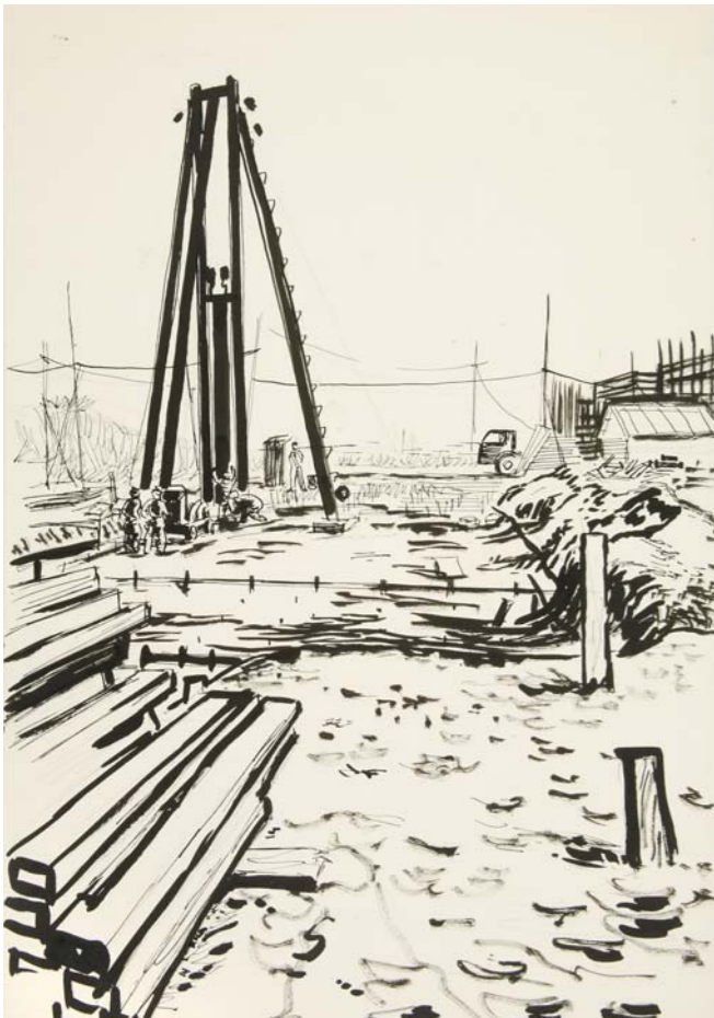
Het heien van palen. Tekening van Nic Blans Sr., 1956 Het gedreun van de heipalen die in de veen kleigrond geslagen werden heeft nog decennia lang geklonken.
