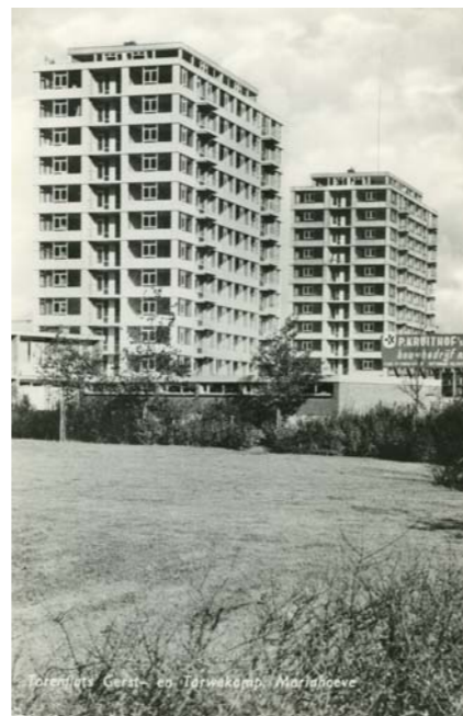
Tarwekamp 1966, foto Hoogland, Drie hoogbouwflats voor het ABP, architect Fiolet, gebouwd door Raadgevend ingenieursbureau Bish en partners
