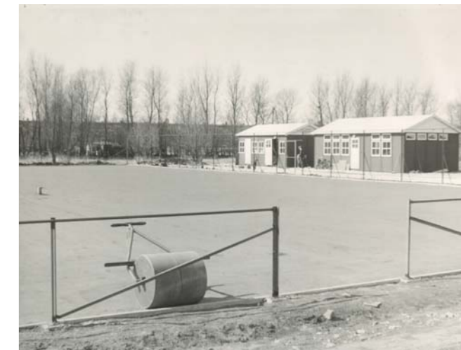
In 1962 werd het land tussen Kleine Loo en Vlaskamp opgehoogd met puin uit het Bezuidenhout, dat door bombardementen in de tweede oorlog kapot was gemaakt. Aangerold met de rollers die je op deze foto ziet!
