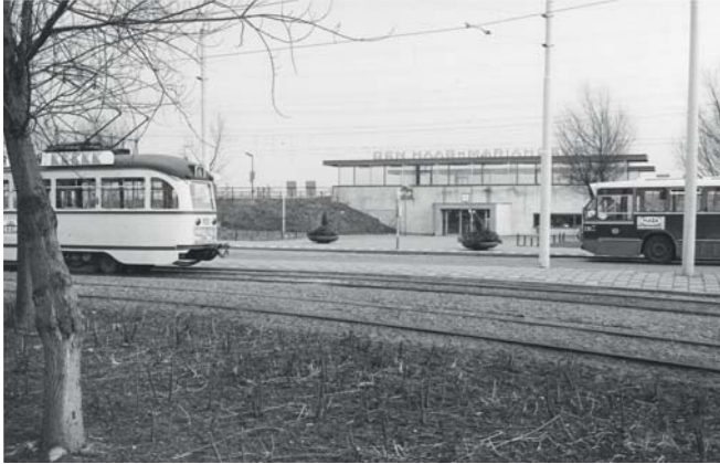
Station Mariahoeve gezien vanaf de Haagse kant in 1973
